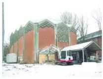
Ein Bagger hat Teile des Eingangsbereiches abgerissen. Der ehemalige Durchgang wurde nunmehr provisorisch mit Holzplatten abgedichtet Foto: Röhe
